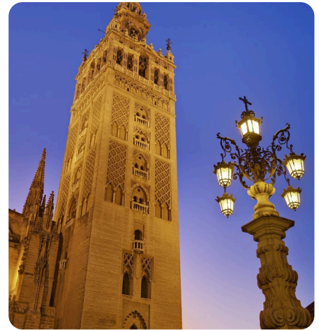
La Giralda , alminar (torre para la llamada a la oración) de la gran mezquita almohade de Sevilla, de finales del s. XII. El campanario y el Giraldillo son del s. XVI. Fijate en los paños de rombos de ladrillo: decoración almohade, sobria y geométrica.
